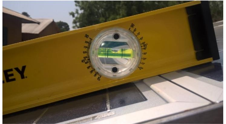
*Mesures et vérification du schéma électrique, de l'inclinaison Sud-Est 15° et du bon fonctionnement du système*
